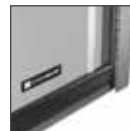
PROFIL BAS AVEC JOINT EN EPDM PROFLO BASSO CON GUARNIZIONE EPDM
